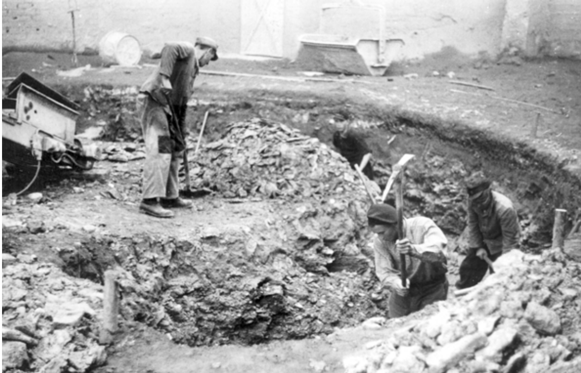
Aushub der Fundamente eines neuen Silos, um 1960
