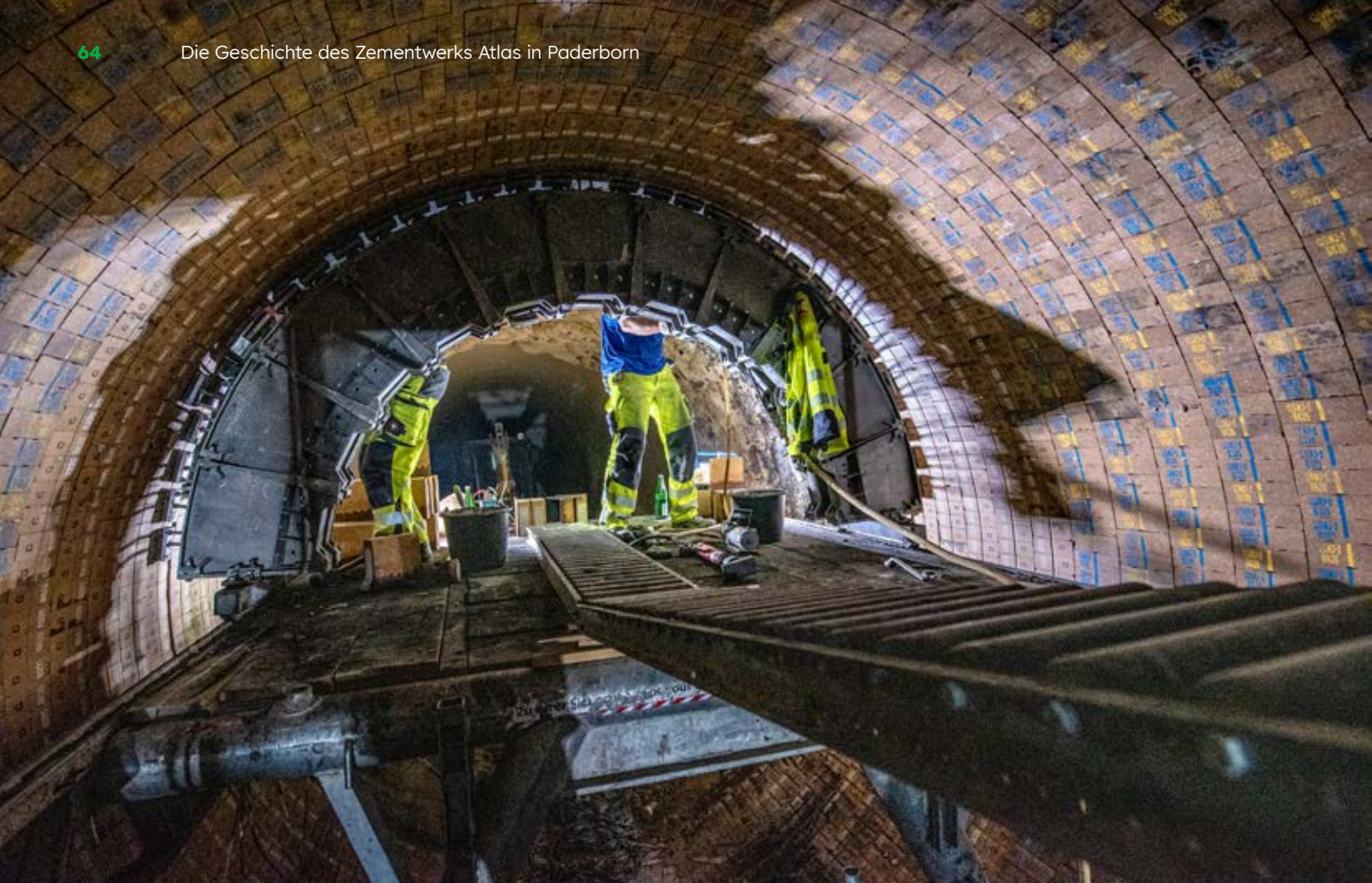
Ausmauerung des Ofens, 10.8.2021 (Foto: Steffen Fuchs)
