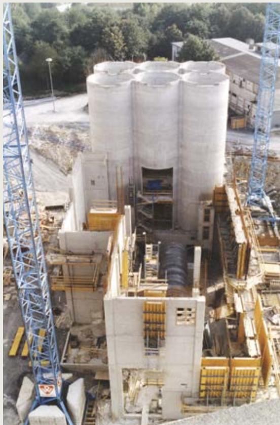
Bau der neuen Zementmühle, 1995
