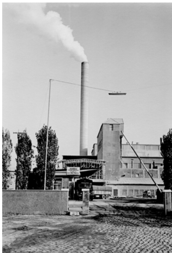
Die Werkseinfahrt um 1955. Im Hintergrund der im Jahr 1953 errichtete Kamin für die Entstaubung der Schachtöfen
