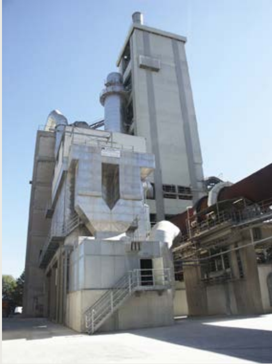
Neue Filteranlage am Drehofen, 2006
