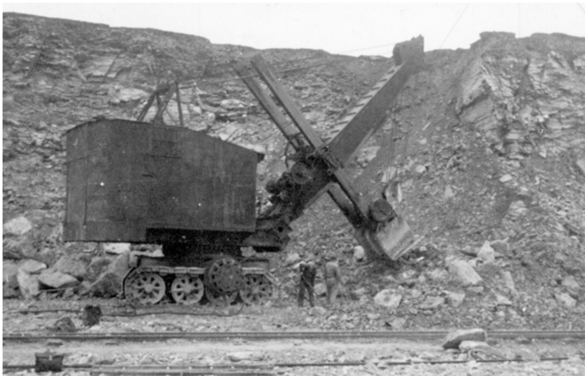
Elektrolöffelbagger im Steinbruch Atlas, um 1935
