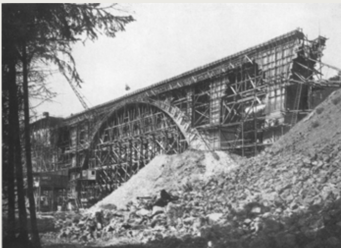
Eisenbahnbrücke über das Dreibrunnertal bei Eisenberg in der Pfalz, erbaut aus Zement der Paderborner Portland-Zementwerke, um 1930
