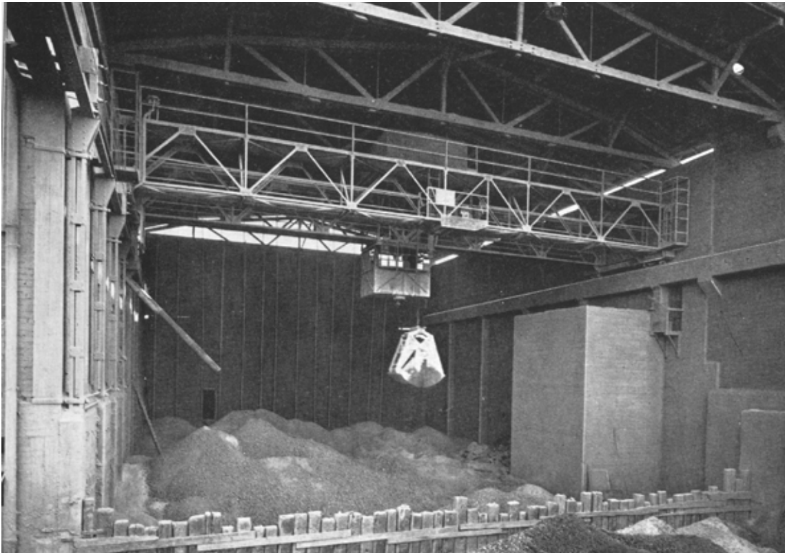
Klinkerlager mit Greifkran, um 1928
