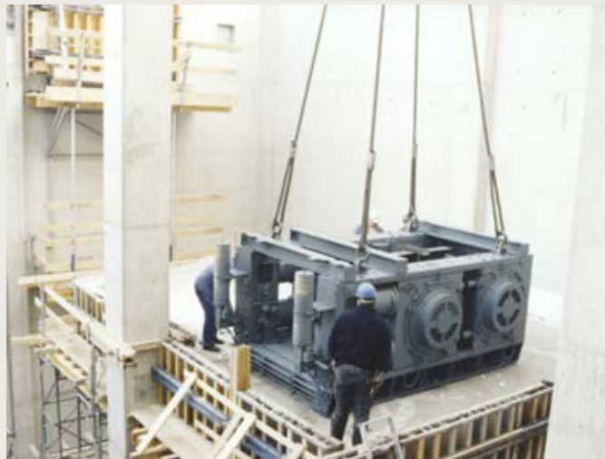
Platzierung der Gutbettwalzenmühle, 1995
