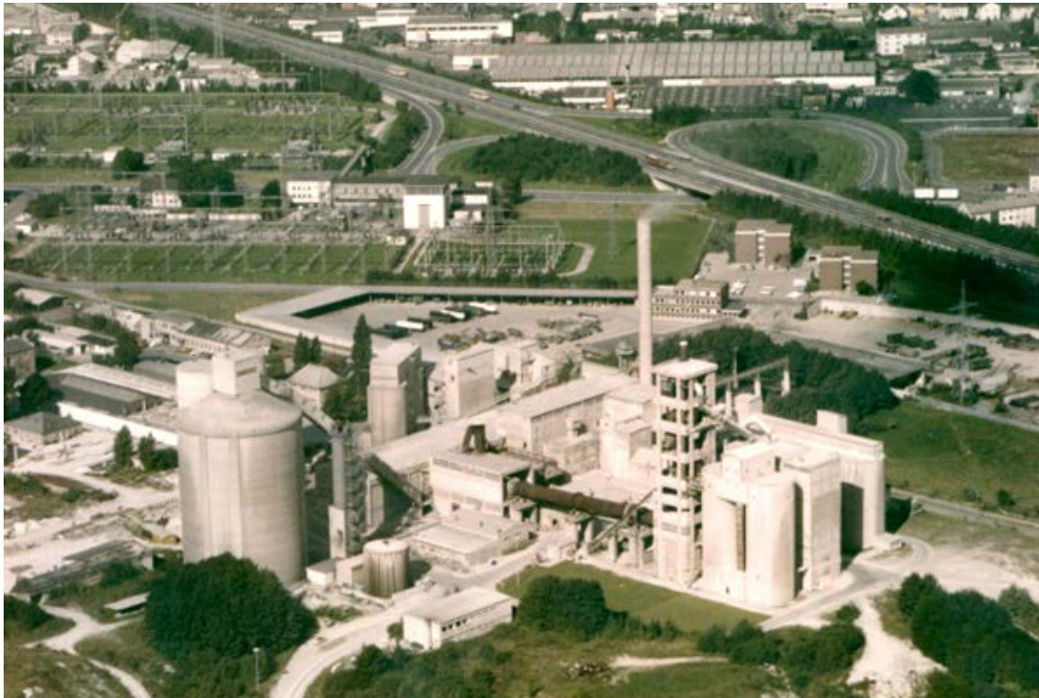
Werksansicht vom Südosten aus dem Jahr 1979. Die Umgehungsstraße und die Stromleitungen zum Umspannwerk im Hintergrund setzten eine Grenze zur Werksenerweiterung nach Norden.
