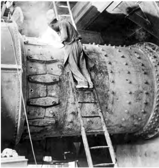
Ältere Aggregate mussten wegen Materialmangel notdürftig repariert werden. Aufschweißen von Laschen auf das gerissene Mühlenrohr, 28.9.1953
