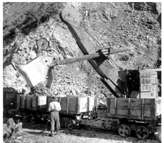
Menck-Bagger M152 bei der Beladung von Loren mit Holzbeplankung im Steinbruch Wachtl, 1953
