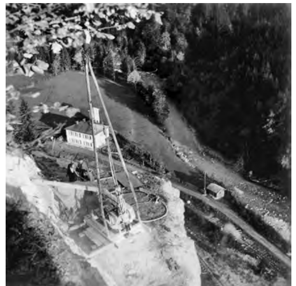
Bohren von Sprenglöchern für die dritte Großbohrlochsprengung mit Salzgitter Bohrmaschine H 60, Bohrtiefe 70 m, 20.10.1954
