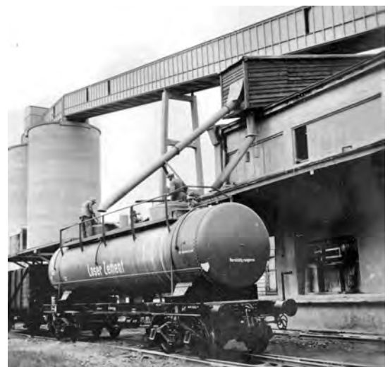
Lose Zementverladung in Eisenbahnkesselwagen, um 1958
