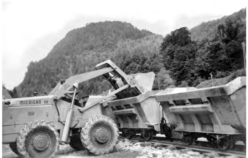
Probeladebetrieb mit einem Michigan 125A-Schaufellader, 20.7.1956
