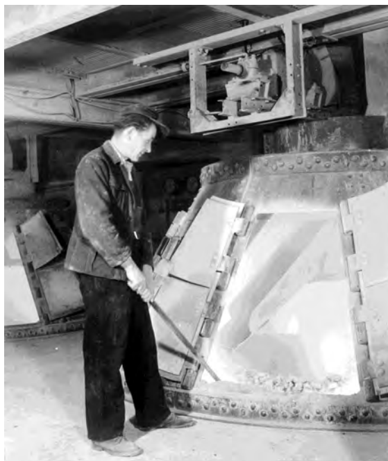
Gichtbühne des Schachtofens. Bei nicht ausreichender Luftzufuhr bestand stets die Gefahr von austretendem CO-Gas, 1952
