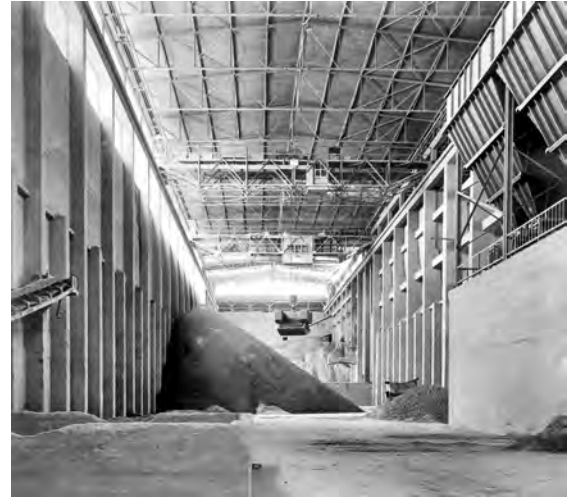
Klinkerlagerung in der neuen geschlossenen Klinkerhalle reduzierte die Staubemission bei Ladevorgängen erheblich, 1952
