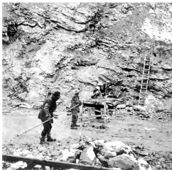
Sprenglochbeladung für 4. Großbohrlochsprengung, Vorbereitung des Hebeschusses zum Steilstellen des Wandfußes, 19.4.1956
