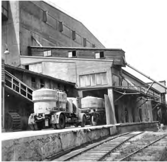
Umständliches Rangieren der Fahrzeuge für den Lose Zementtransport vor der Packerei, 25.2.1953 und 3.7.1953
