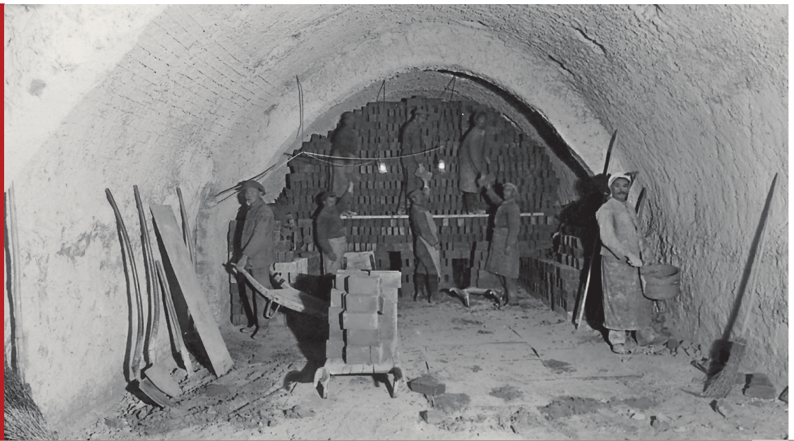
BELADUNG DES RINGOFENS mit Rohmehlsteinen, 1927.
