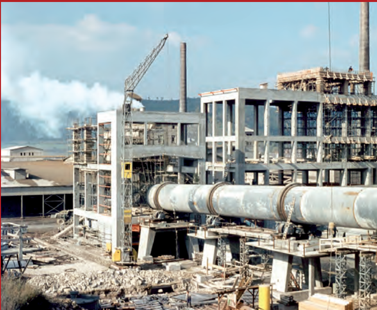
Neuer SCHWEBEGAS-WÄRMETAUSCHEROFEN im Bau, 1971.
