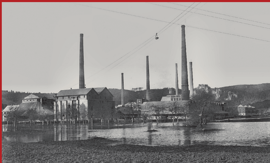
PORTLAND-CEMENTFABRIK, GEBRÜDER SPOHN von Süden gesehen. Es kreuzen sich die Seilbahnen aus Sotzenhausen und vom Stuttgarter Werk nach Gerhausen. Im Vordergrund links das Doppelschachtofengebäude und rechts ein Ringofen, ca. 1930.
