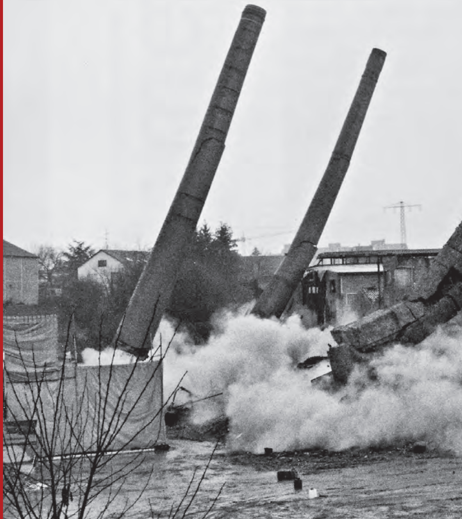
SCHORNSTEINSPRENGUNG im Oberschwäbischen Cementwerk Ehingen am 9.04.1928.
