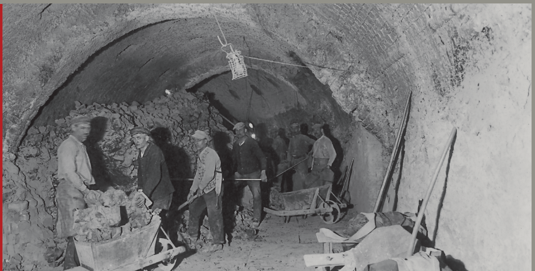
HERAUSBRECHEN DER KLINKER aus dem 70 m langen und 28,3 m breiten Ringofen, 1927.
