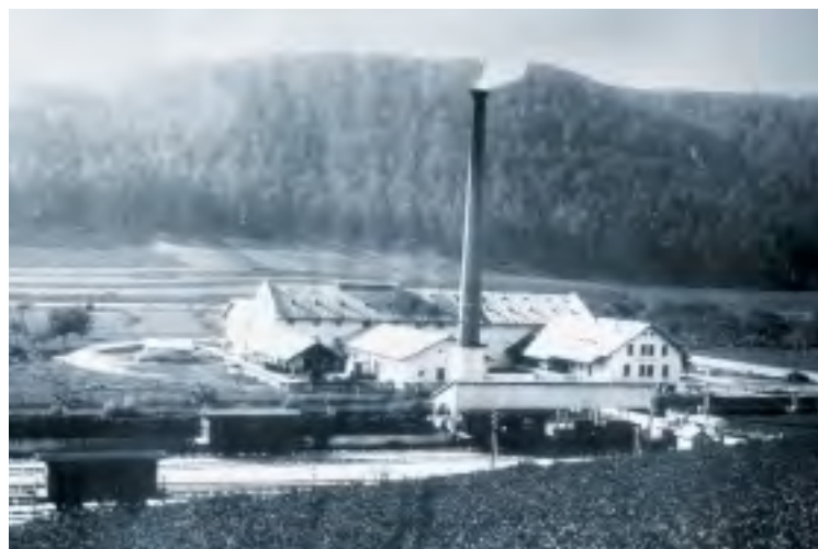
Altteste Fotografie der Firma »Gebrüder Spohn«, um 1876. Die Fabrik besitzt noch keine Ofenanlagen, denn die Kalksteine werden in Sotzenhausen, Allmendingen und Gerhausen gebrannt. Die Fabrik besteht aus dem langgestrecktem Mühlengebäude mit quer angebauten Maschinen- und Kesselhaus mit Kamin. Rechts liegt das Magazin- und Verwaltungsgebäude.
