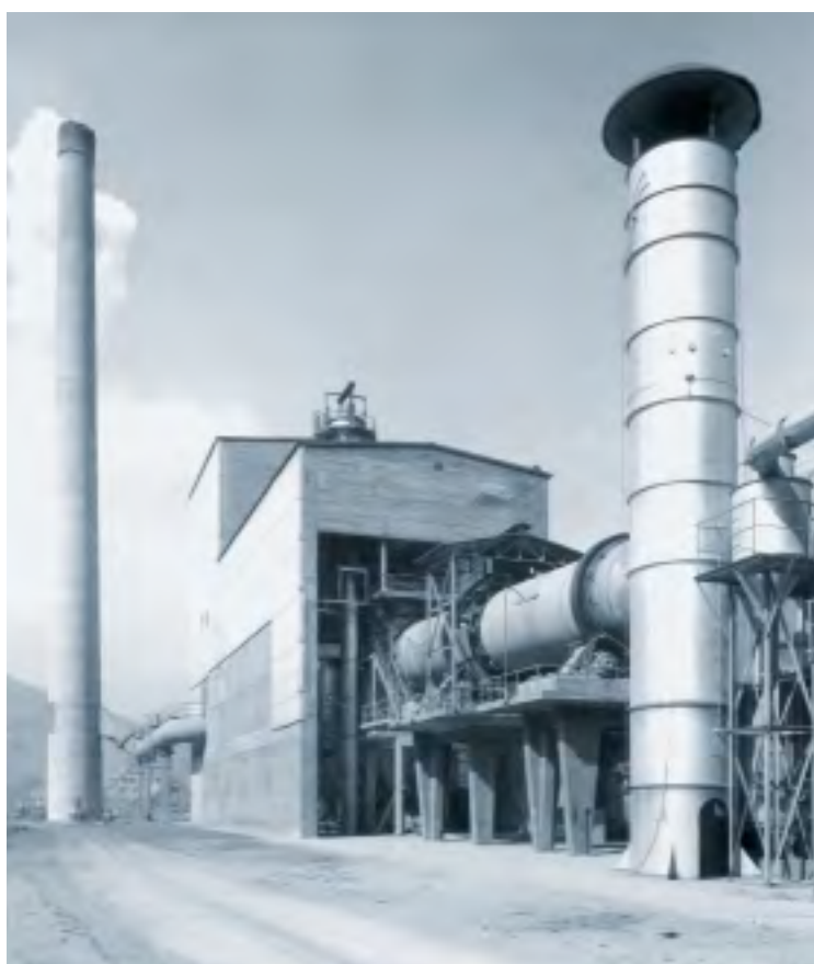
Ofengebäude des Lepolofen II, 1965.
