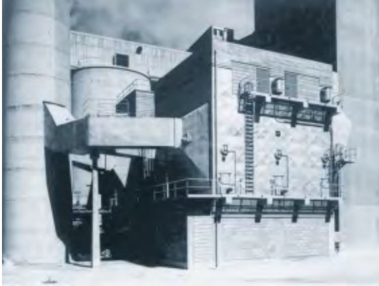
Neue elektrische Gasreinigung, 1965.
