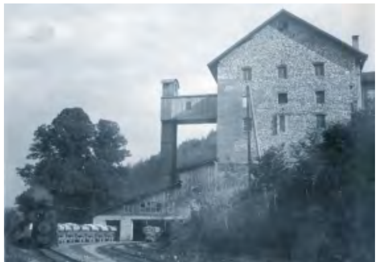
Verladestation der Gebrüder Spohn AG in Gerhausen. Die Materialbelieferung erfolgte aus dem oberhalb gelegenen Bruch, die Rollbahn mit 700 mm Spurweite führte durch Gerhausen zum Werk.
