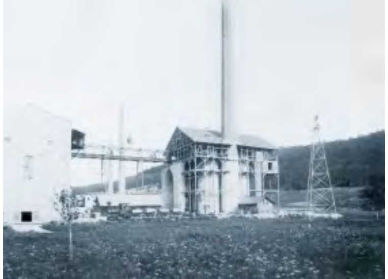
Drahtseilbahn nach Sotzenhausen, links »Cementstein-Magazin«, rechts 3 Schachtöfen mit 62 Meter hohem Rauchabzugskamin, ca. 1898.
