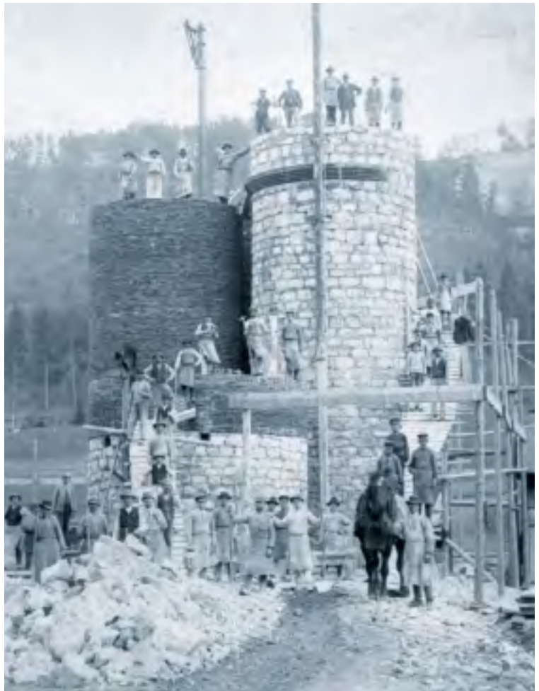
Errichtung von Schachtöfen, um 1898. Nach der Errichtung der automatischen Schachtöfen 1918 wurden diese Öfen stillgelegt und Ende der 1920er Jahre abgebrochen.
