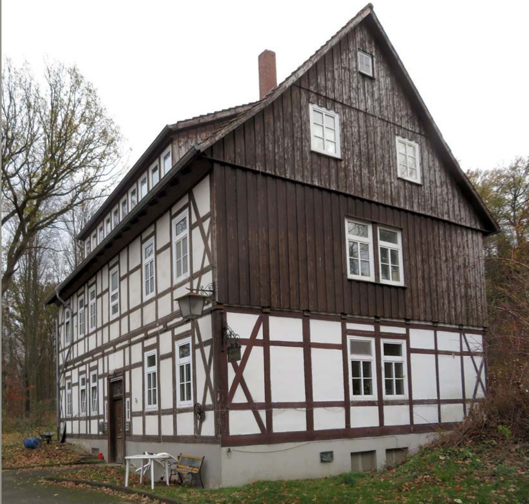
Altes Zollhaus Seesen, ehemaliges WOHNHAUS DER FAMILIE SCHOTT , wiederaufgebaut in Grauhof bei Gosslar. Quelle: Dirk Stroschein/Städtisches Museum Seesen, 2018.
