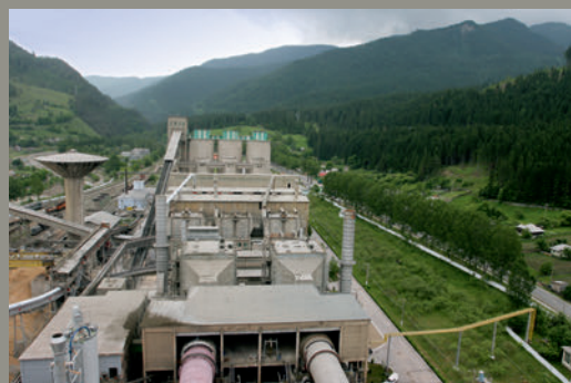
1998 erwarb die Heidelberg Zement AG 51 % an dem rumänischen ZEMENTUNTERNEHMEN MOLDOCIM – S.A. BICAZ , ca. 1990.
