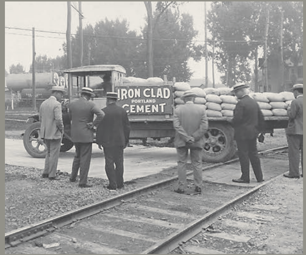
BELASTUNGSVERSUCH an einer Betonstraße mit einem mit 6,5 t Zement beladenen LKW in GLENS FALLS, NEW YORK, 1929.
