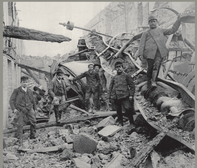
Arbeiter in der alten ZEMENTDAMPFMÜHLE .
