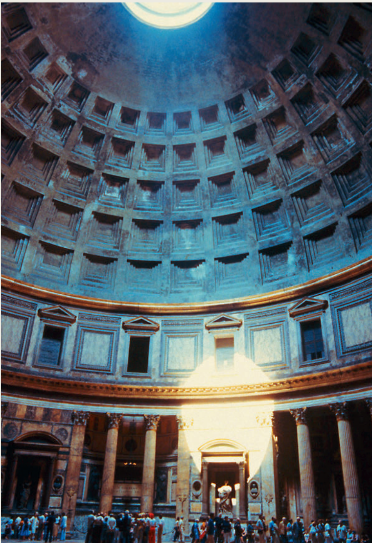
PANTHEON IM ROM. Die Mauern sind großenteils aus mit Ziegeln ummauertem OPUS CAEMENTITIUM gebaut und ruhen auf einem 7,50 m breiten und 4,60 m tiefen Ring aus Gussmauerwerk als Fundament. Für die Kuppel wurde der Beton mit leichtem vulkanischen Tuff- und Bimsstein vermischt. Zur weiteren Gewichtersparnis wurde sie durch fünf konzentrische Ringe aus je 28 Kassetten gegliedert, wobei die Kassetten der einzelnen Ringe nach oben hin immer kleiner werden. Am Scheitelpunkt der Kuppel befindet sich eine kreisrunde Öffnung von neun Metern Durchmesser, das Opaion, das neben dem Eingangsportale die einzige Lichtquelle des Innenraums darstellt. Um das hierdurch eindringende Regenwasser abzuleiten, ist der Boden des Kuppelsaals leicht zum Zentrum hin aufgewölbt.
