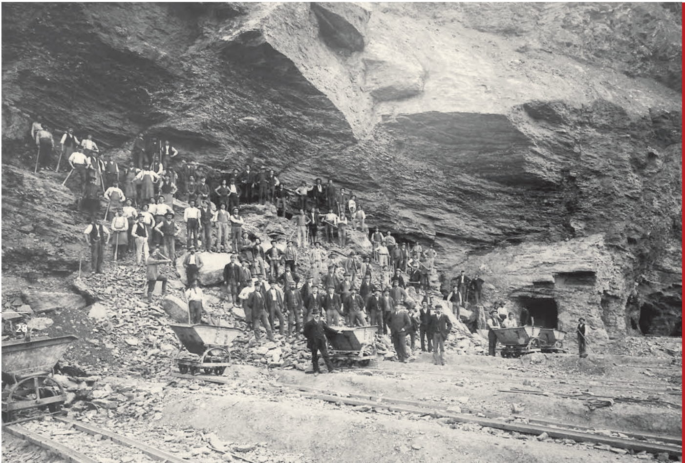
Ab 1879 wurde der STEINBRUCH ROHRBACH an der Gemarkungsgrenze zu Leimen in eigener Regie betrieben. Als Abbaumethode wurde der Rüdersdorfer Sturzbetrieb gewählt, 1895.
