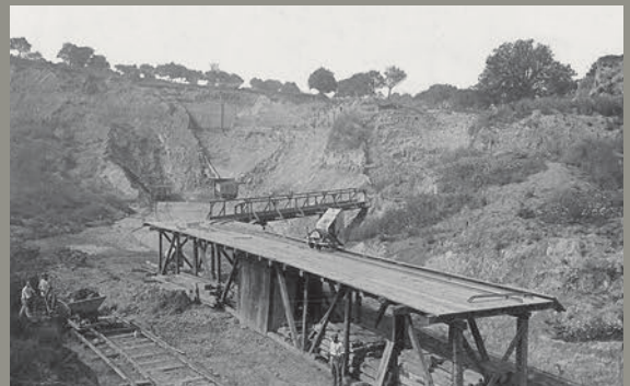
HANDBABU im Steinbruch und Verladung auf offene Waggons mittels Verladerrampen, 1893.
