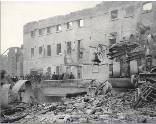
ROHMÜHLENGBÄUDE , davor Kollergang zur Vorzerkleinerung.
