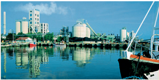
ZEMENTWERK SLITE auf der schwedischen Insel Gotland, ca. 2000.
