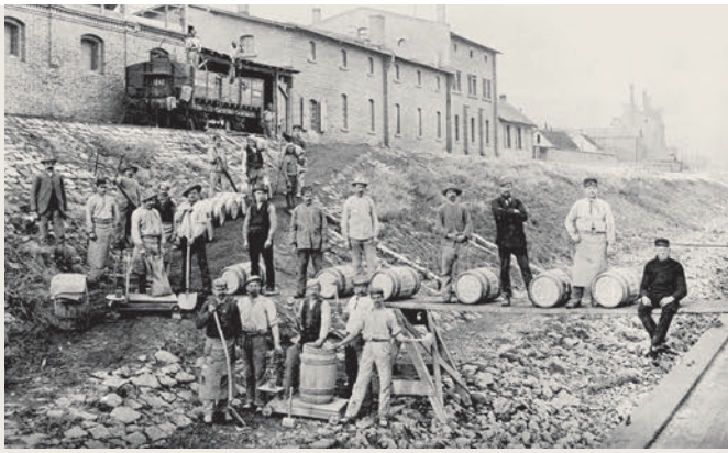
▲ SCHIFFSVERLADUNG von Zementfässern am Neckar.
