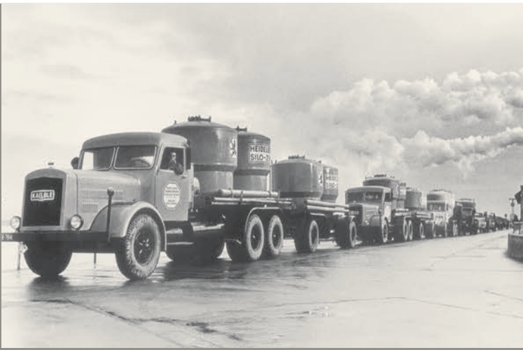
SILO-LKWS im Zementwerk Weisenau, ca. 1953.
