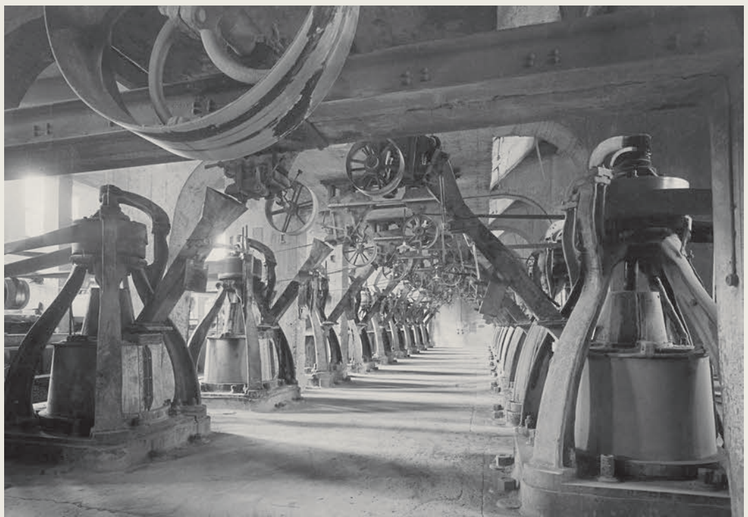
Transmissions- getriebene GRIFFIN-MÜHLEN , nach dem Wiederaufbau, ca. 1930.
