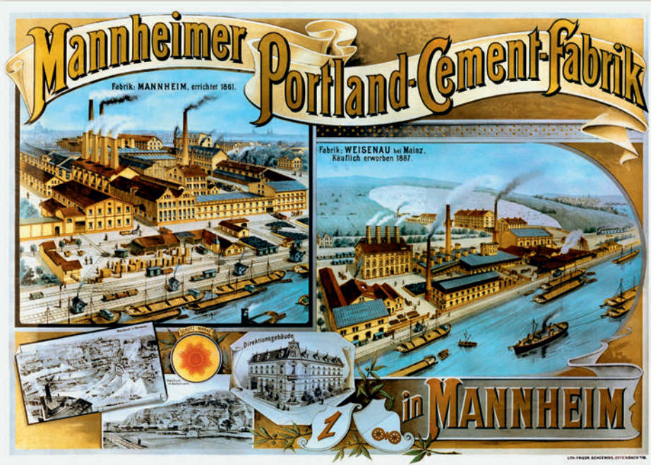
◀ MANNHEIMER PORTLAND-CEMENT-FABRIK nach dem Mannheimer Werksumbau und des neuen Zweigwerks in Weisenau bei Mainz, 1890.
