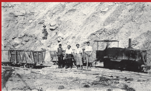
ARBEITER BEIM STEINBRECHEN und verladen in die Feldbahnwagen, ca. 1920.
