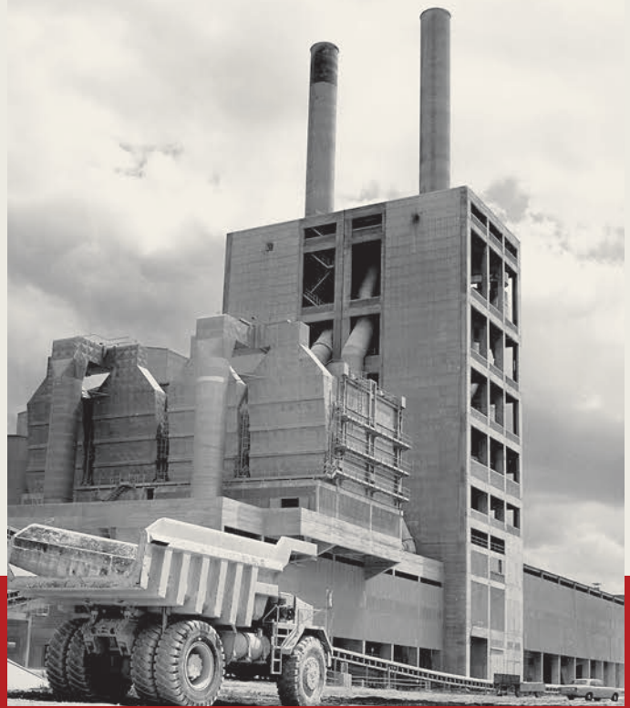
NEUER WÄRMETAUSCHEROFEN im Zementwerk Burglengenfeld, 1974.
