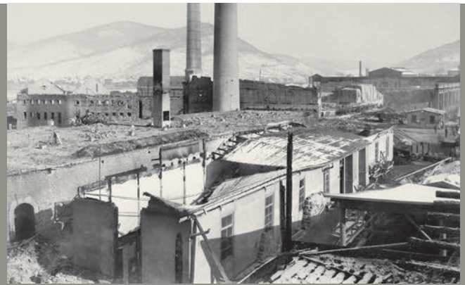
Im Vordergrund hinter dem Schuppen RINGOFEN III , links dahinter ROHMÜHLENGBÄUDE , rechts hinten Zementlager- und Versandhalle.
