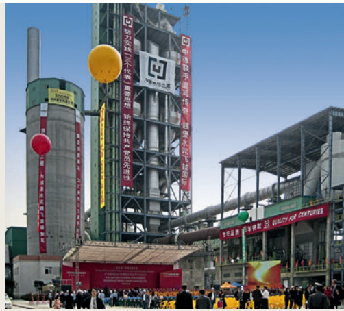
INBETRIEBNAHME des neugebauten ZEMENTWERKS GUANGZHOU in der chinesischen Provinz Guangdong mit einer Kapazität von 2,3 Mio. t am 02.04.2005.
