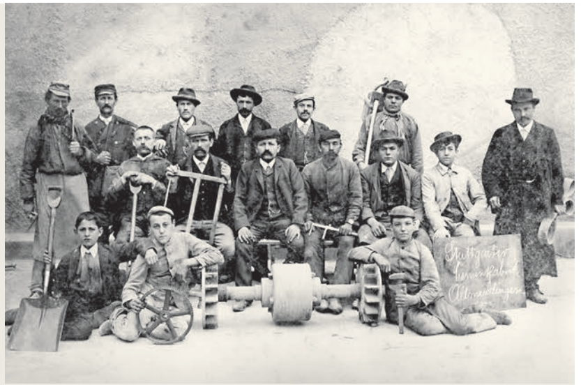
ARBEITER DER STUTTGARTER CEMENTFABRIK in Allmendingen, 1900.
