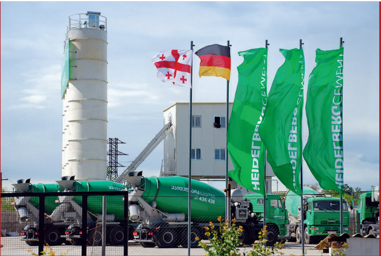
Nach dem Markteintritt in den Zementmarkt in Georgien wurde 2009 das erste TRANSPORTBETONWERK IN PONCHIALA in der Nähe der Hauptstadt Tiflis erbaut, 2009.
