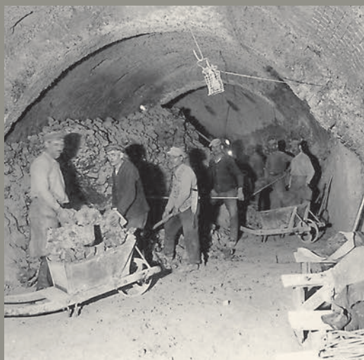
HERAUSBRECHEN DER KLINKER aus dem Ringofen, 1927.
