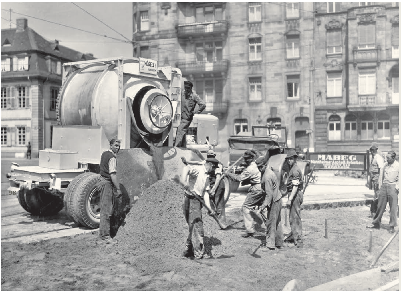
ARBEITSDIENST IN MANNHEIM, im Hintergrund einer der ersten Vögele-Fahrmischer, ca. 1935.
