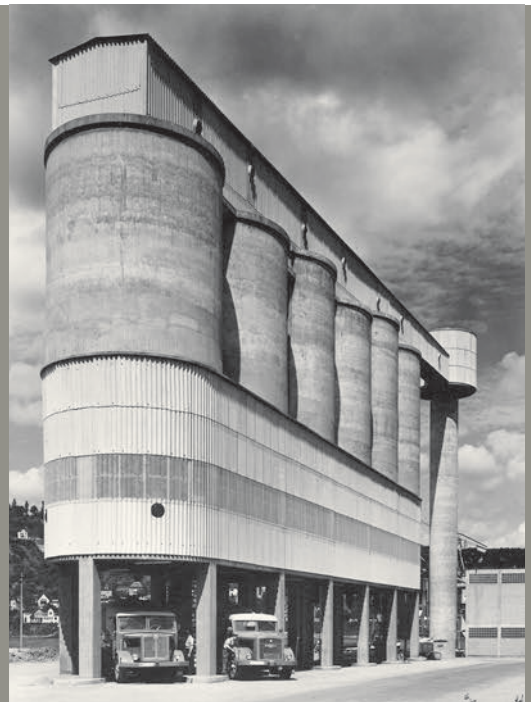
ZEMENTUMSCHLAGSANLAGE in Andernach, 1961.
