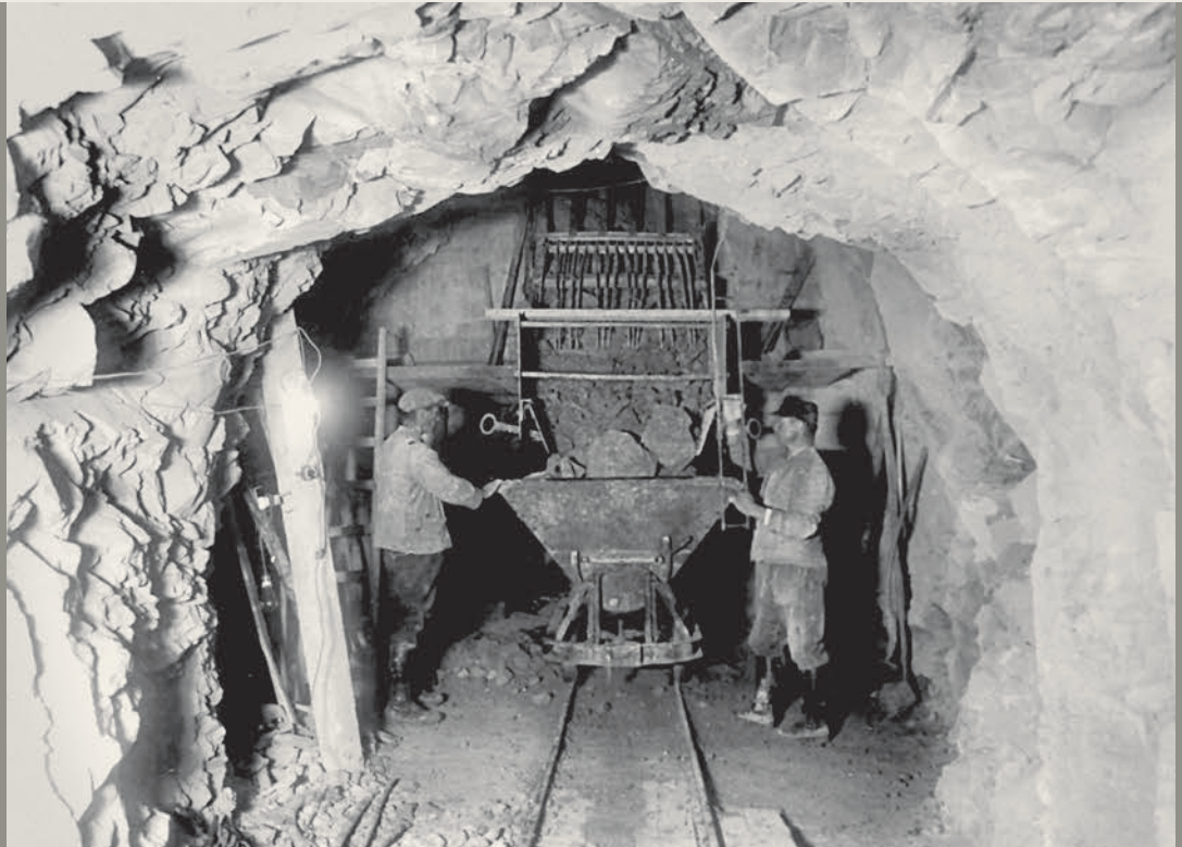
ABFÜLLSCHNAUZE im horizontalen Stollen, ca. 1935.
