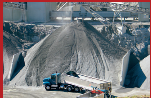
ZUSCHLAGSTOFFWERK WOLFDENE in Australien, 2005.
