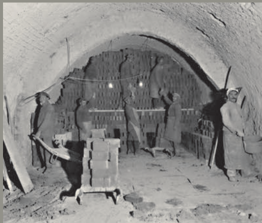
BELADUNG DES RINGOFENS mit Rohmehlsteinen, 1927.
