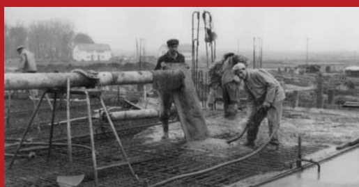
BETONIEREN DER KELLERDECKE im Audi-Werk Ingolstadt mit Hilfe von BETONPUMPEN, 1935.
