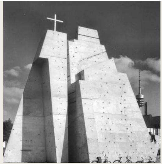
BETONKLETTERFELSEN im Olympiapark in München, Oktober 1972.
