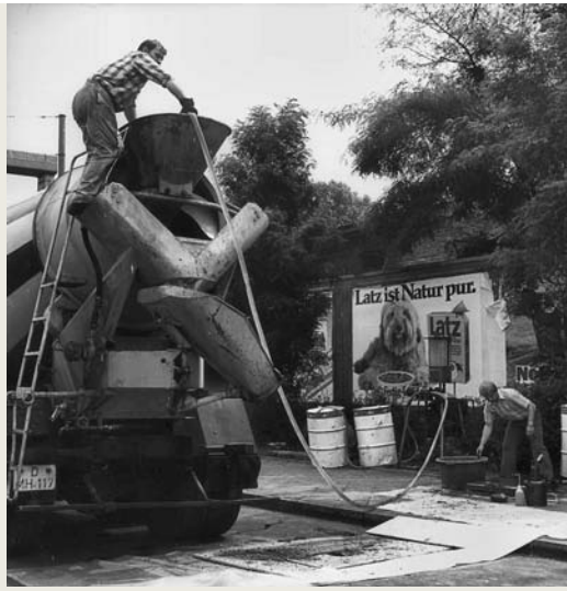
FLIESSBETONBAUSTELLE in Düsseldorf, August 1977.
