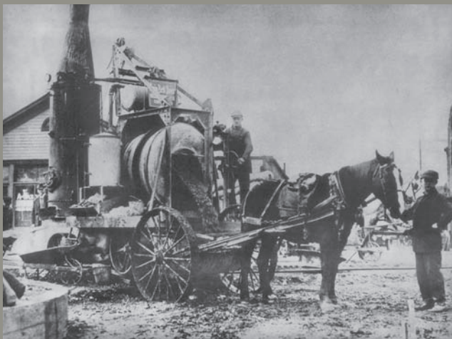
FAHRBARER BETONMISCHER, Chain Belt Paver, blieben noch viele Jahre lang für die Bereitung von Ortbeton im Einsatz, ca. 1920.
