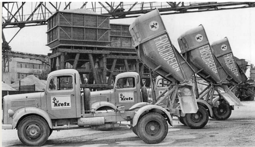
TREFZ-FRISCHBETONANLAGE im Stuttgarter Hafen, 1954.
