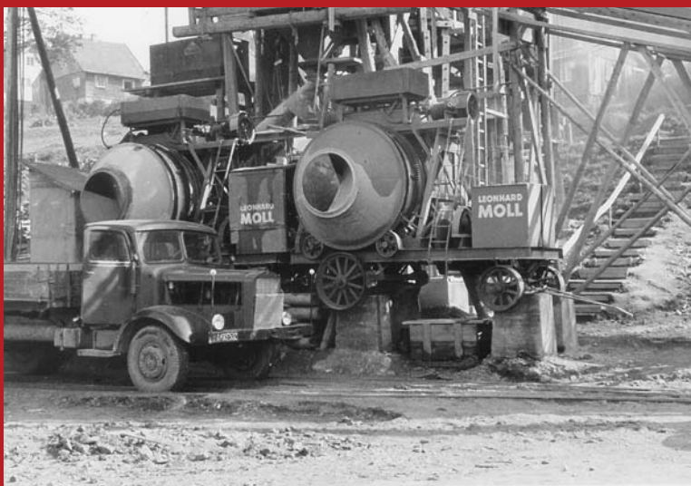
BELADUNG EINES LKWs aus der stationären Mischanlage Leonhard Moll.
