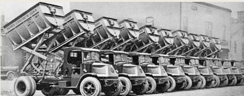
SPEZIALKIPPWAGEN , die den Beton während des Transports dauernd in Bewegung hielten und vor dem Abkippen nochmals durchmischten, ca. 1928.
