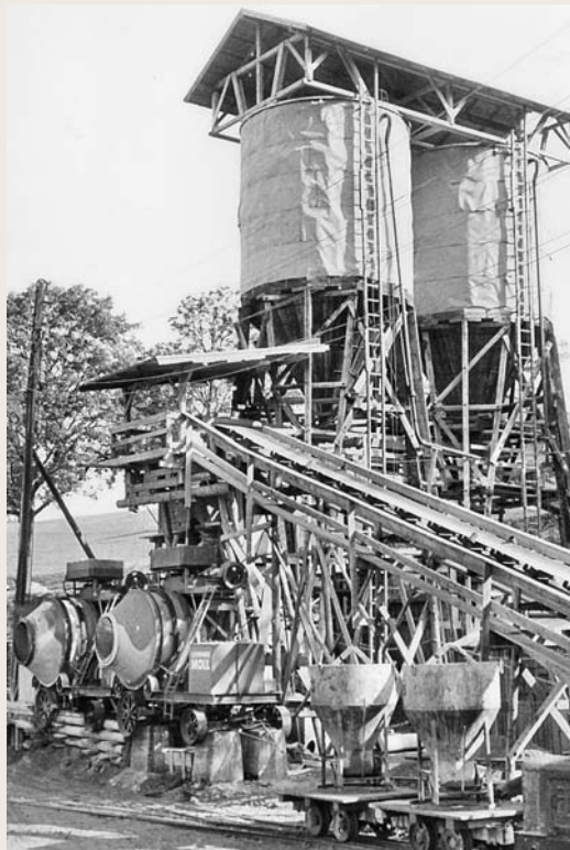
BETONMISCHANLAGE MIT KIPPLORENTTRANSPORT der Arbeitsgemeinschaft Kraftwerk Reggen in Landshut, 15.10.1954.
