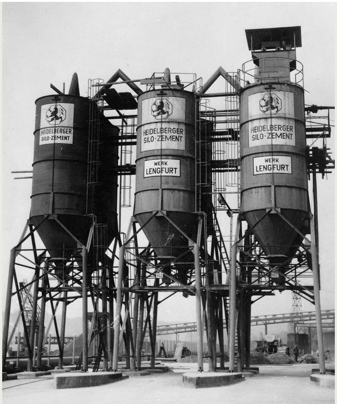
BAUSTELLENSILOS des Zementwerks Lengfurt, ca. 1955.
