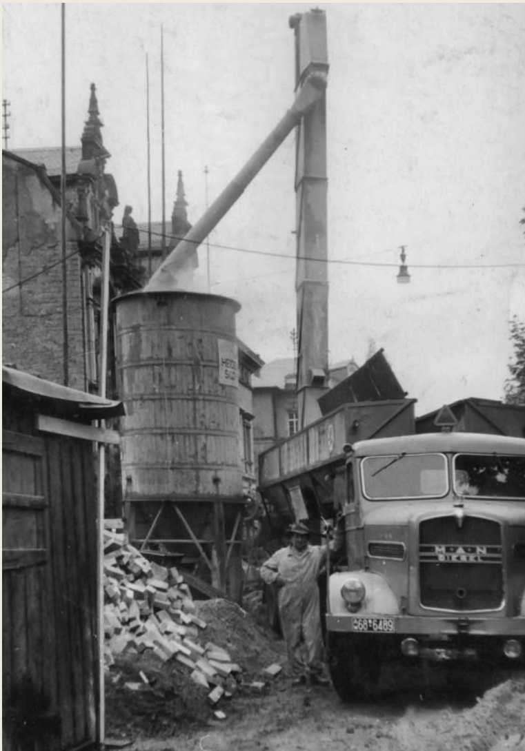
BELADEN eines HEIDELBERGER BAUSTELLENZEMENT-SILOS durch die Spedition Zizmann unter beengten Verhältnissen, 1953.
