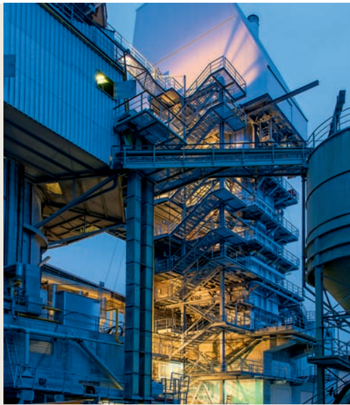
Der neue GGR-DOPPELSCHACHTOFEN 400 t/d, Ansicht aus Südwesten zwischen Ringschachtofen 7 und Filterstaubsilo.
