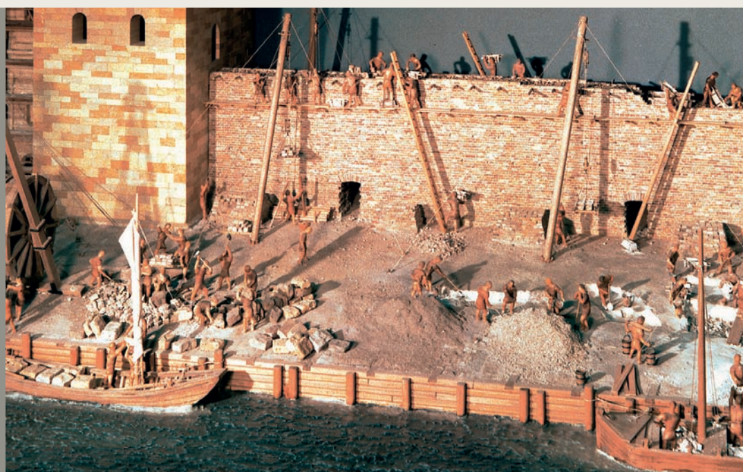
Modell der Errichtung des STEINKASTELLS
