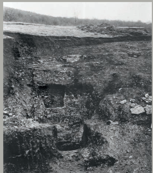
Ausgrabung zweier römischer Kalköfen im Steinbruch Rohrbach, 1903.
