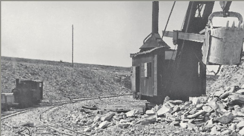
Steinbruchbetrieb mit **DAMPFBAGGER** und **DAMPFLOK**, ca. 1940.
