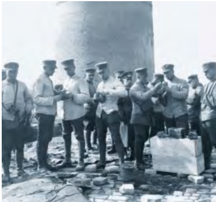
Vorbereitung der Sprengung des 60 m hohen Schornsteins der Ringöfen II und III durch Pioniere aus Ulm 1936. Oberst Kreuzer hatte mehrfach Georg Spohn gebeten das Kamin sprengen zu dürfen. Nach der Sprengung waren die in die umliegenden Felder gefallenen Steine rasch von Steinesammlern aufgelesen.
