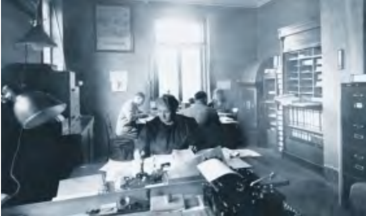
Das alte Bürogebäude (Gebäude 1) gehörte zu den ältesten Bauwerken der Fabrik. Im Laufe der Jahre war es als Zementmagazin, Unterkunftsräume für fremde Arbeiter, Labor, Comptoir und Waagstube genutzt worden.
