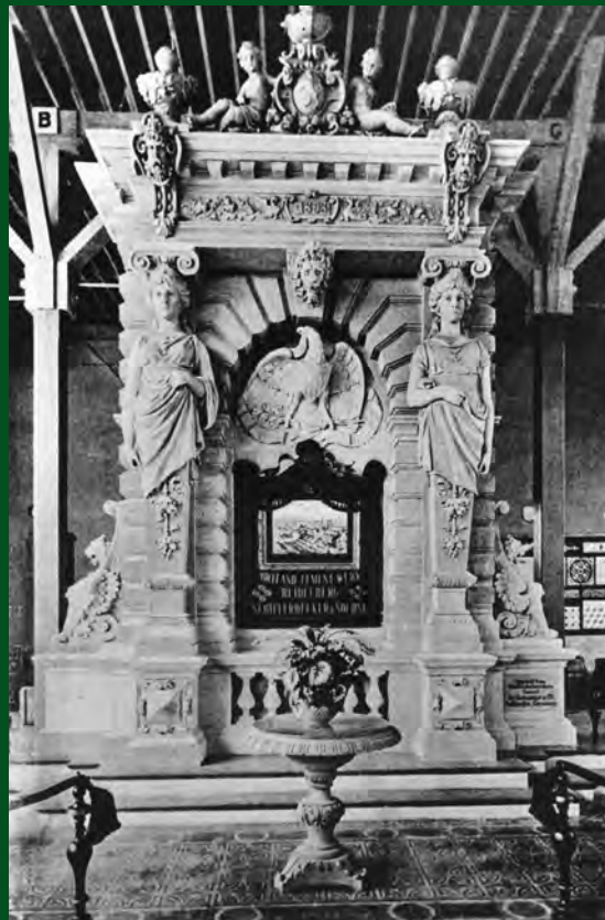
Ausstellungsobjekt des Portland-Cement-Werks Heidelberg für die Weltausstellung in Chicago 1893, hergestellt von der Firma Brenzinger & Cie, Freiburg
