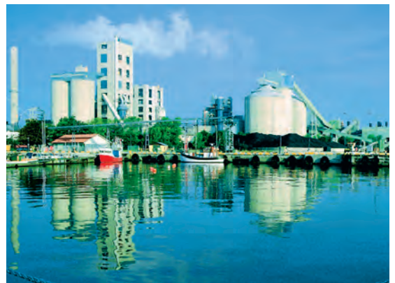
Zementwerk Slite auf der schwedischen Insel Gotland, ca. 2000
