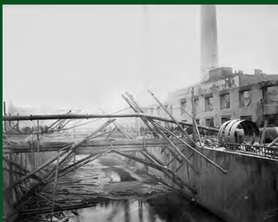
Mühlkanal, rechts Zementmühlengebäude
