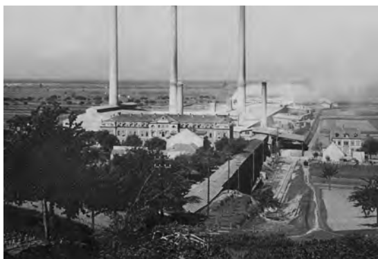
Blick von Osten auf das neue Werk. Links der 1898 errichtete siebte Ringofen. Im Vordergrund die überdachte Straßenüberführung der Lorenbahn, 1900
