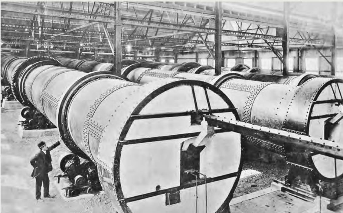
Charles A. Matcham (*15.1.1862 Torquay †22.9.1911 Allentown), Gründer der Lehigh Portland Cement Company, an den Drehöfen in Evansville, 40 km südwestlich von Allentown, Pennsylvania, kurz vor der Inbetriebnahme, 1909
