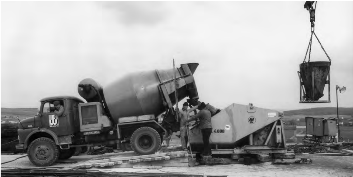
Fahrmischer an der Fuldabrücke, Mai 1967
