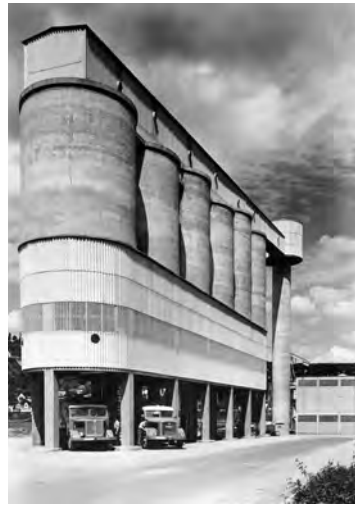
Zementumschlagsanlage in Andernach, 1961
