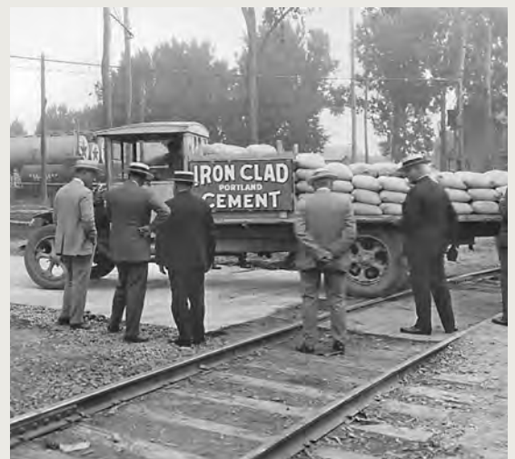
Belastungsversuch an einer Betonstraße mit einem mit 6,5 t Zement beladenen Lkw in Glens Falls, New York, 1929
