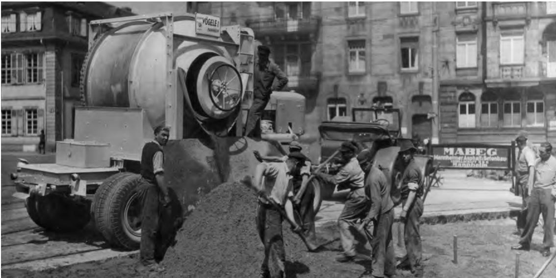
Arbeitsdienst in Mannheim, im Hintergrund einer der ersten Vögele-Fahrmischer, ca. 1935
