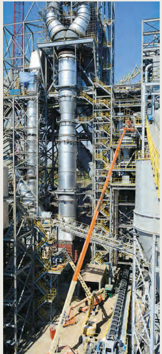
Wärmetauscherofen des Werks Union Bridge im Bau, 2002
