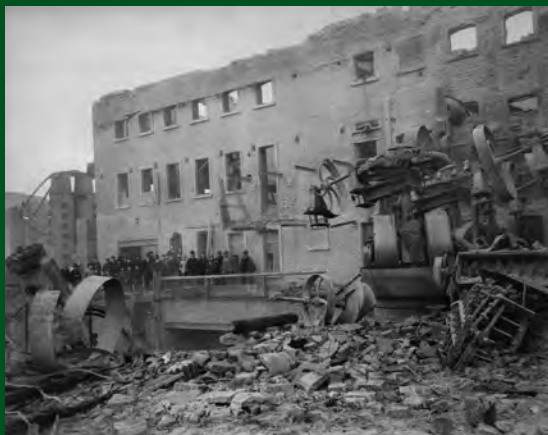
Rohmühlengebäude, davor Kollergang zur Vorzerkleinerung
