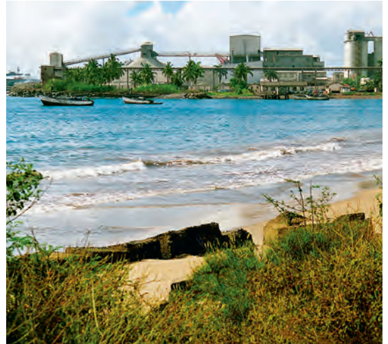
Ghacem Zementwerk Takoradi in Ghana, ca. 2000
