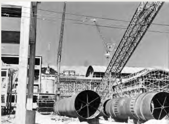
Bau eines Zementwerks in Monselice, 26.7.1958
