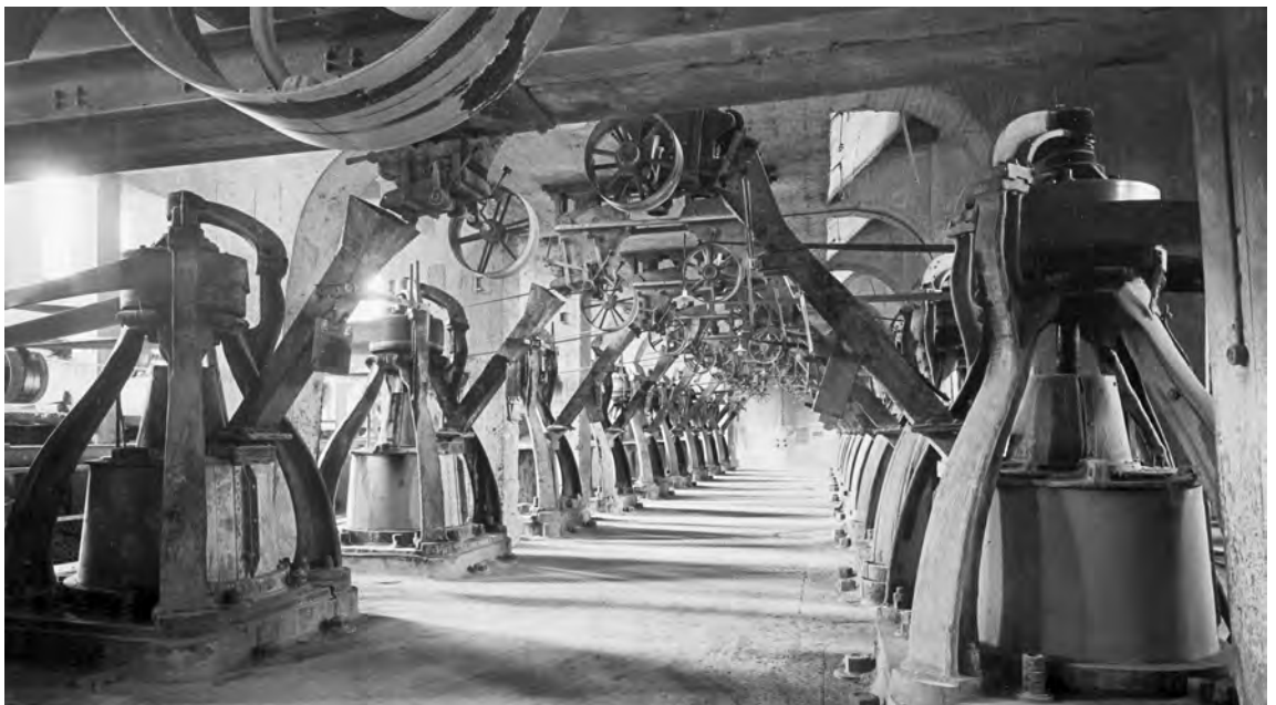
Transmissionsgetriebene Griffmühlen nach dem Wiederaufbau, ca. 1930
