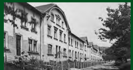
Reihenhäuser in der Zementwerkstraße, 1910
