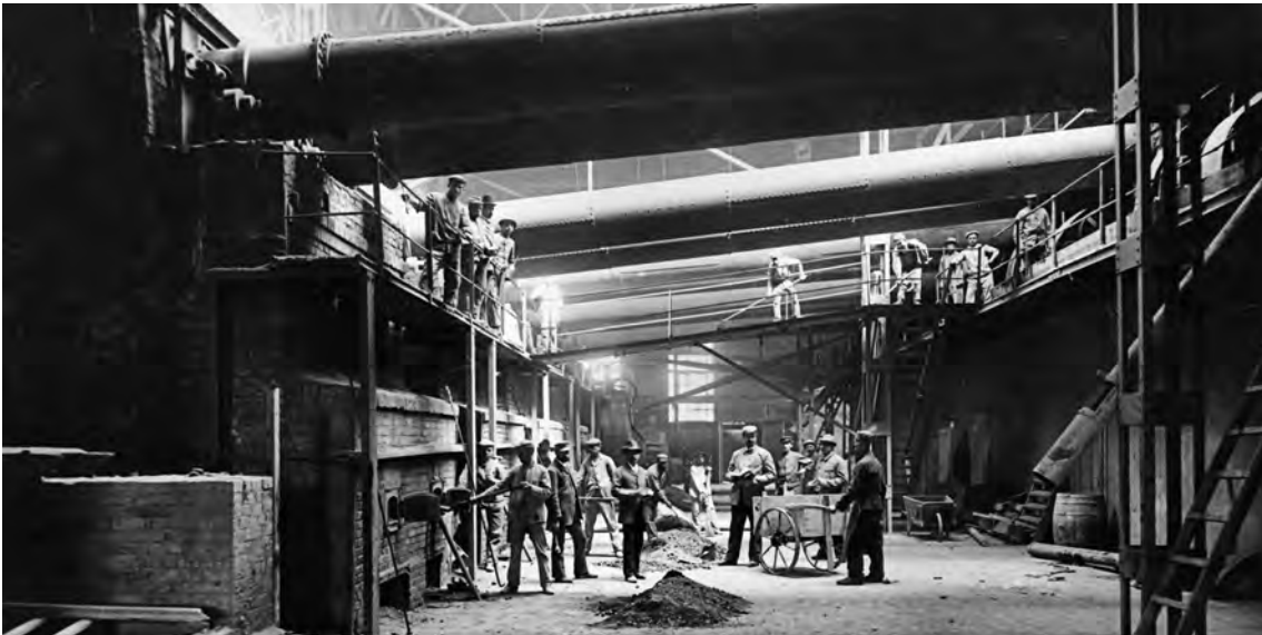
Mit Kohle befeuerte Trockentrommeln, vor der Abhitzeverwertung, 1900
