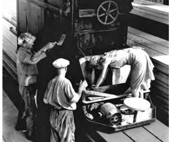
Herstellung von Betondeckenbalken im Betonwerk Leimen. Frauen waren im Betonwerk immer wieder beschäftigt, ca. 1946.
