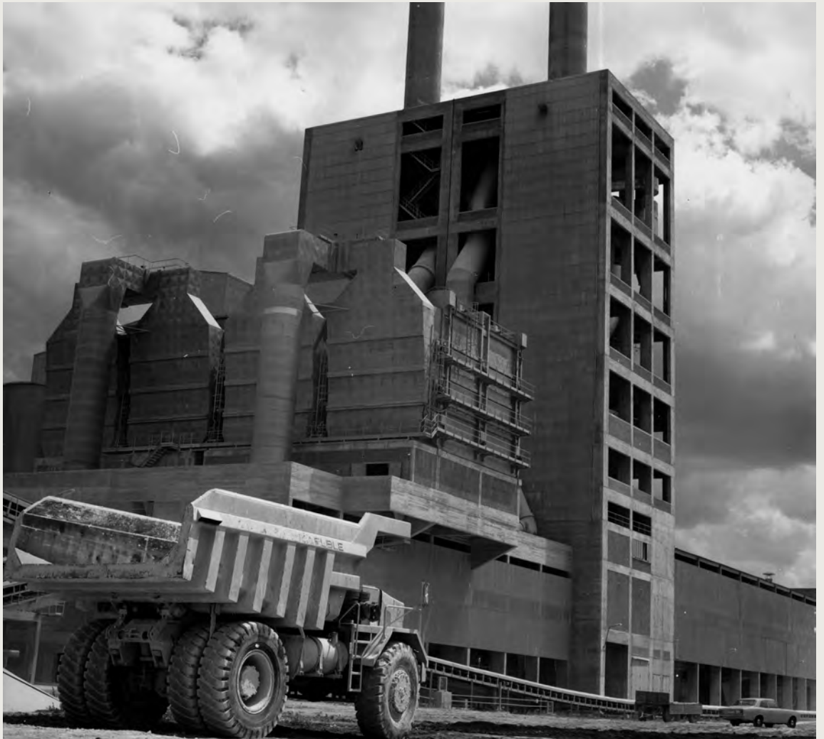
Neuer Wärmetauscherofen im Zementwerk Burglengenfeld, 1974
