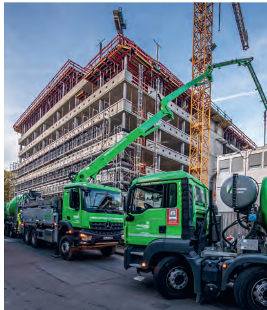
Betonage des 5. Obergeschosses, 18.10.2018. Foto: Steffen Fuchs
