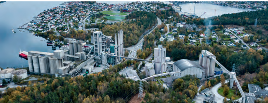
Im norwegischen Zementwerk Brevik entsteht die erste CO 2 -Abscheideanlage im großindustriellen Maßstab in der Zementindustrie, 2022. Foto: Dag Jenssen
