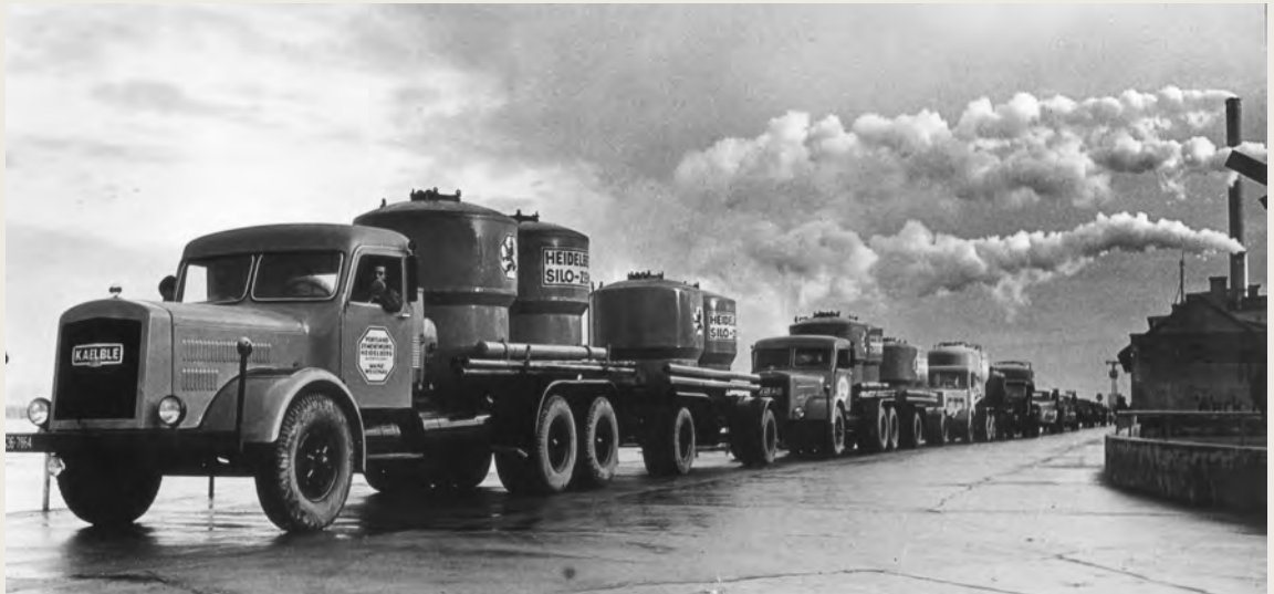
Silo-Lkws im Zementwerk Weisenau, ca. 1953
