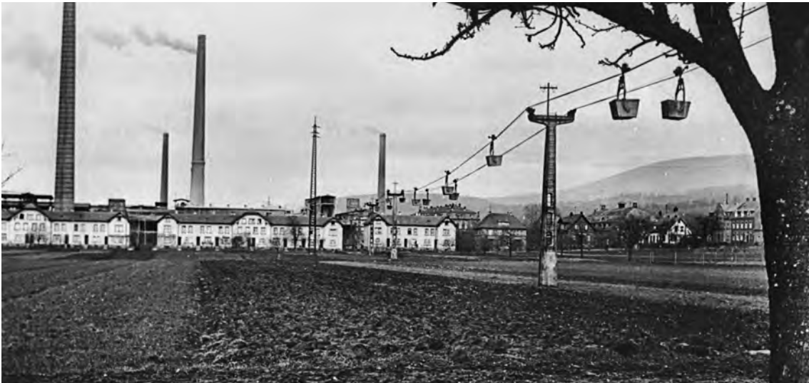
Drahtseilbahn von Leimen nach Nußloch, im Hintergrund die 1908 errichteten Werkshäuser in der Zementwerkstraße, 1920
