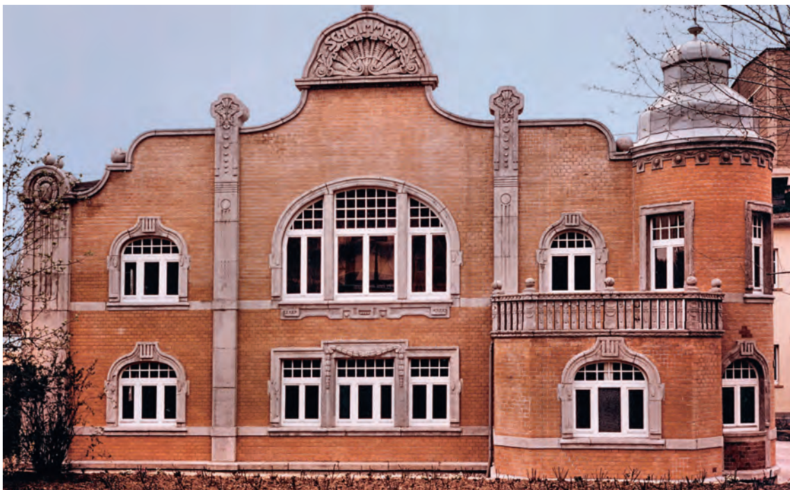
Hallenschwimmbad. Das 600 m 2 große Gebäude ist in Kunststeinen in Kalksteinnachahmung und rötlich-gelben Verblendziegeln ausgeführt. Der Bademeister war im Anbau mit Balkon untergebracht. Über den danebenliegenden Treppenturm gelangte man zum Bad, 1983.
